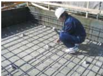
基礎配筋検査
